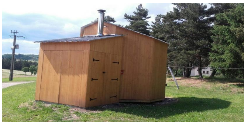
Immagine 6 - Locale caldaia modulare di ERE43 © ERE43
