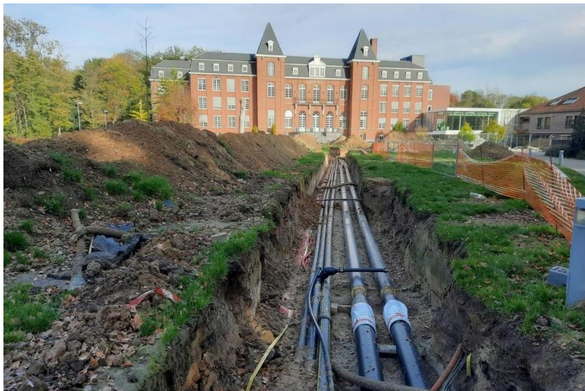
Immagine 8 - Realizzazione della rete di teleriscaldamento © Beauvent, 2022
