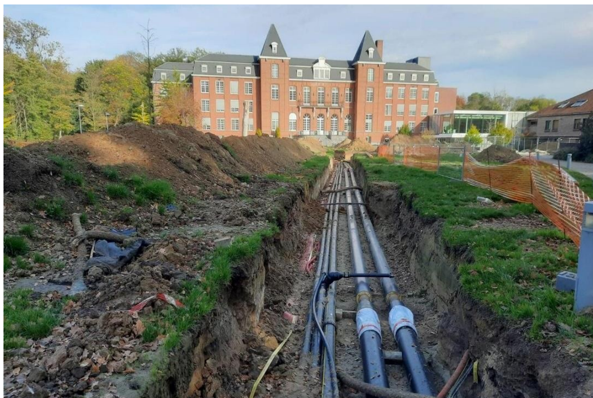
Immagine 8 - Realizzazione della rete di teleriscaldamento © Beauvent, 2022
