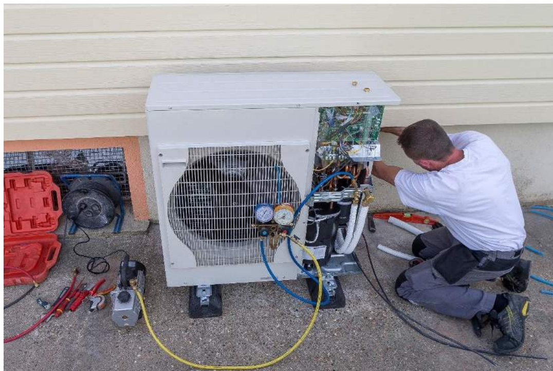
Immagine 4 - Installazione di una pompa di calore © Adobe Stock, JPC-PROD
