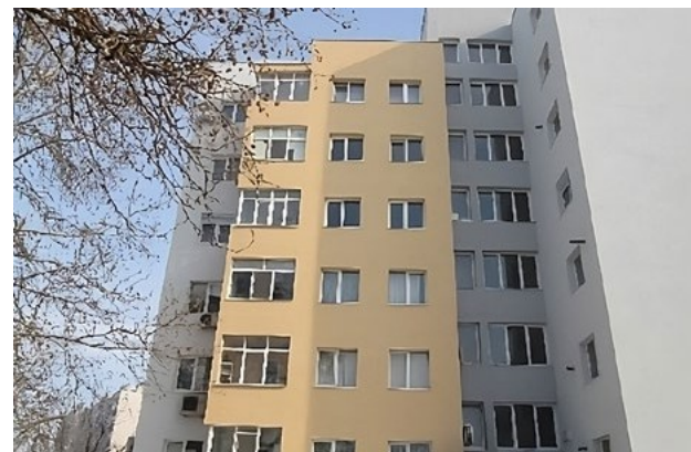
Edificio dopo la ristrutturazione ©Municipalità di Asenovgrad
