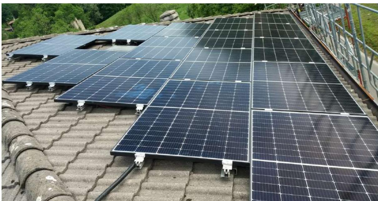
**Impianto fotovoltaico da 11,55 kWp, accumulo da 12,4 kWh e wallbox con pensilina in legno - Casole D'Elsa (SI)**
