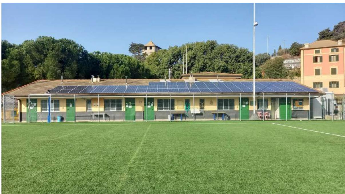
**Impianto fotovoltaico da 5,7 kWp, accumulo da 15 kWh, wallbox e impianto a pompa di calore con sistema radiante - Albino (BG)**
